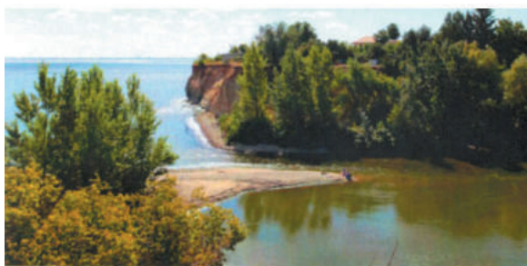
Главной водозабор Городищенской оросительной системы располагается на Волгоградском водохранилище перед плотиной Волжской ГЭС
