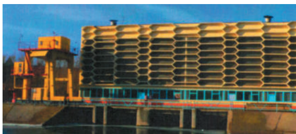
Подача воды в систему осуществляется двумя главными насосными станциями (первого и второго подъема). Производительность каждой из них – 27 м 3 /сек. Суммарная геодезическая высота подъема воды из водохранилища – 120 м.
