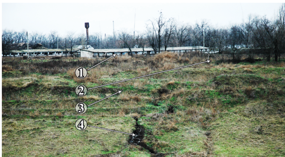
Рисунок 1 – Прорывы сточных вод с территории свиноводческого комплекса на нижележащий участок склона (автор фото А. В. Макаров):
